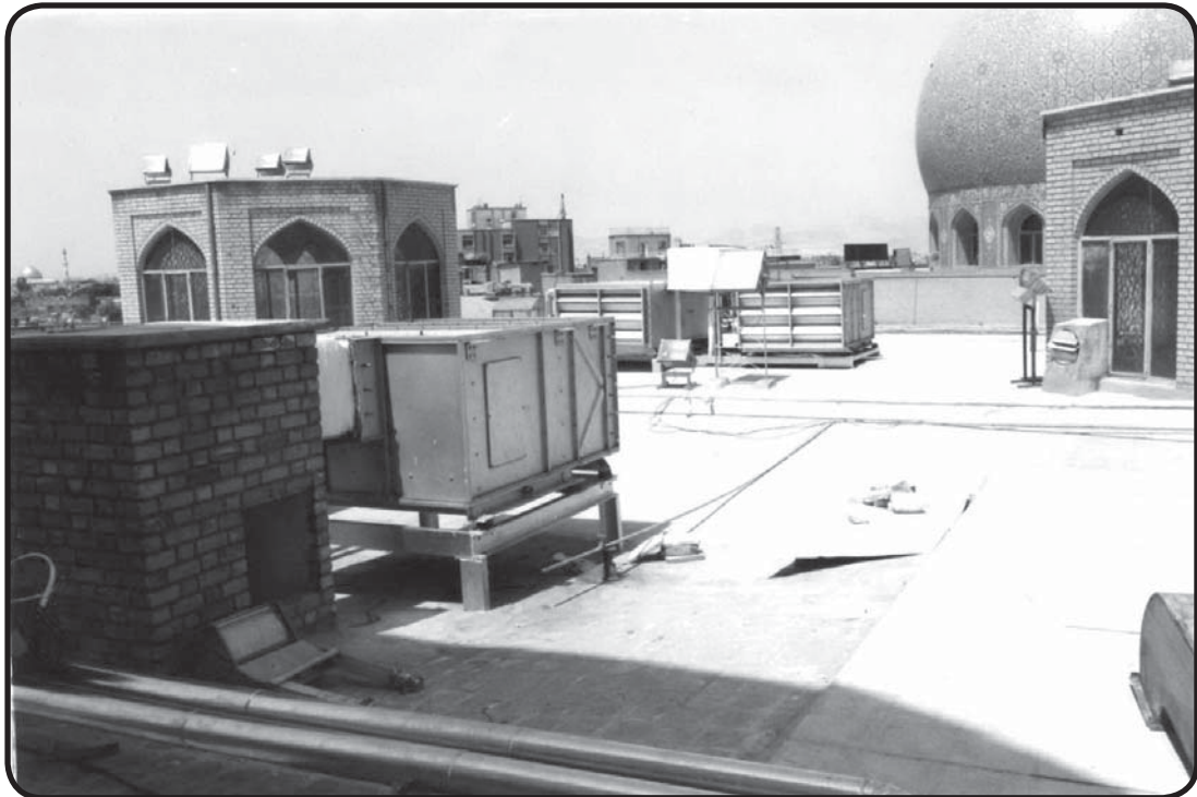
نصب هواساز و کندانسور هوایی حرم مطهر و مسجد اعظم
