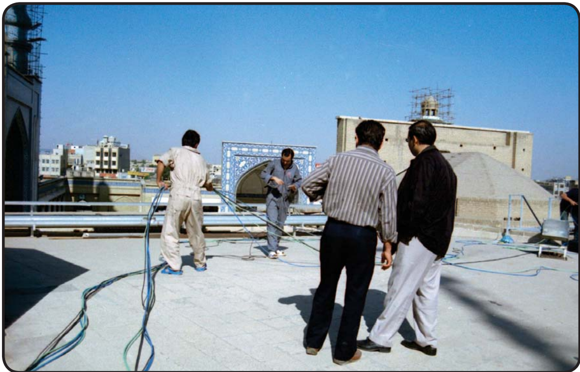
قرار دادن کابل های فیبر نوری در لوله های نصب شده در پشت بام حرم با نظارت یکی از مهندسین مربوطه
