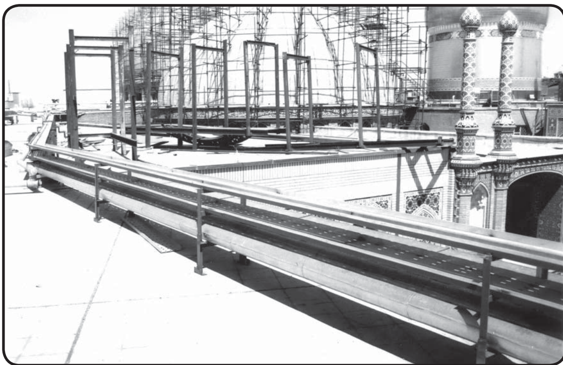
کانال کشی و داکت کشی جهت انتقال کابلها در پشت بام حرم مطهر، دهه ۱۳۸۰
