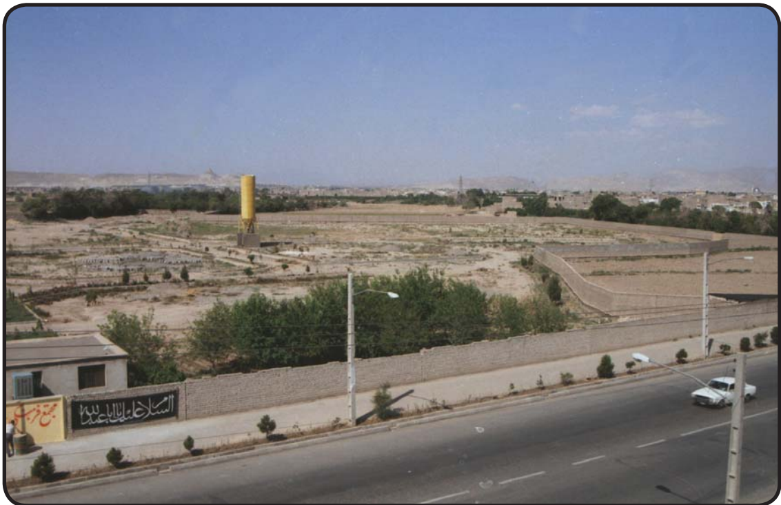
آلبوم روند پیشرفت در پروژه فرهنگی ورزشی آستانه (پژوهشکده علامه طباطبائی)
