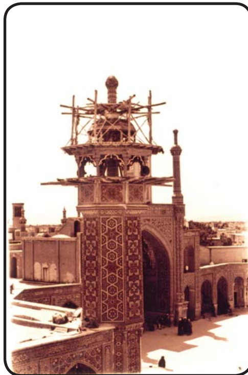
تعمیر گلدسته های ضلع شرقی صحن اتابکی - دهه ۱۳۵۰
