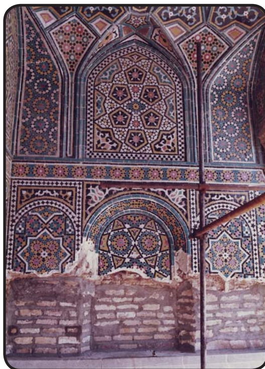
تراشیدن کاشی های فرسوده حجره واقع در صحن اتابکی
