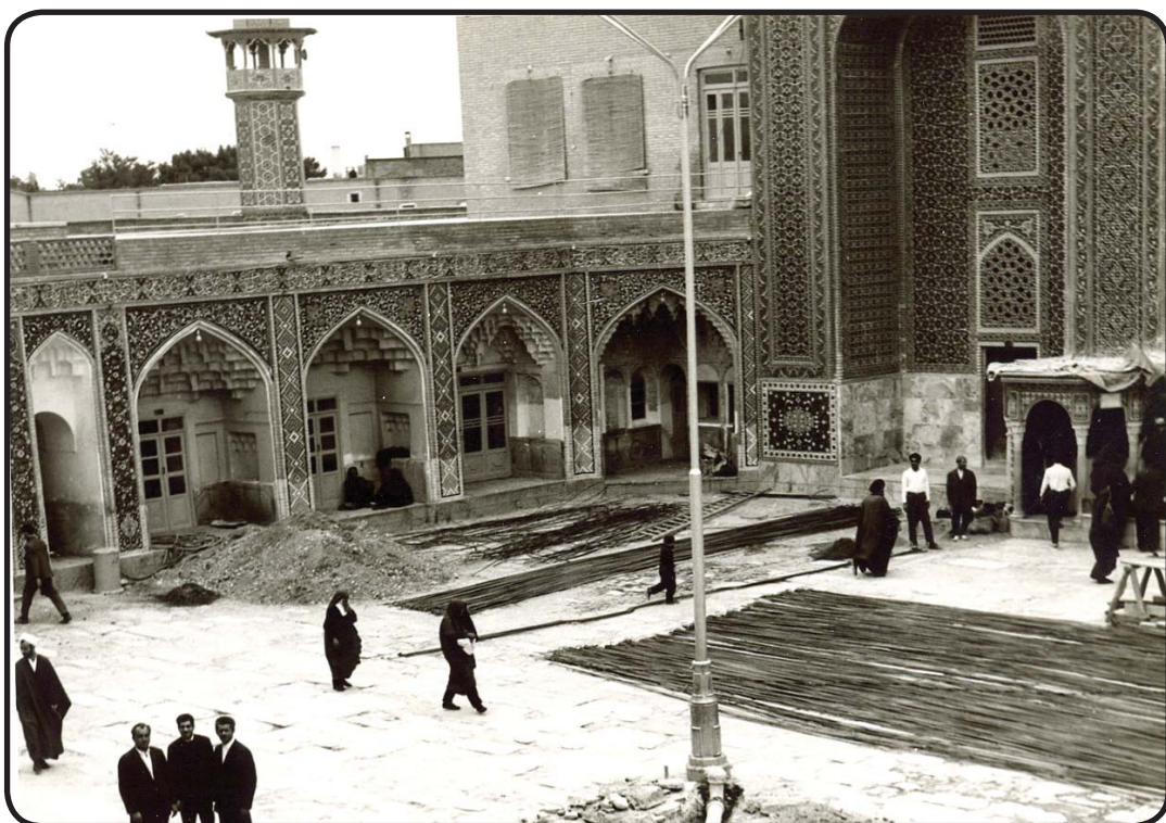
بتن ریزی کف صحن عتیق، سال ۱۳۴۹
