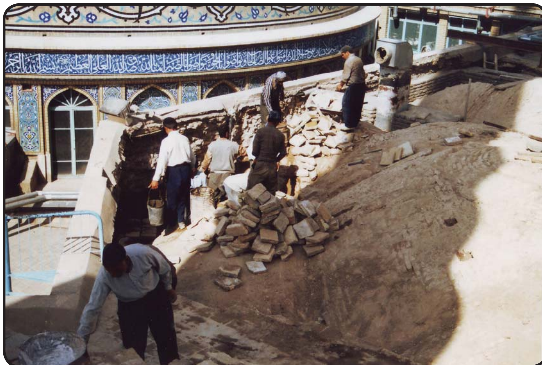
آلبوم تعمیرات ساختمانی پشت بام حرم مطهر، سال ۱۳۷۸
