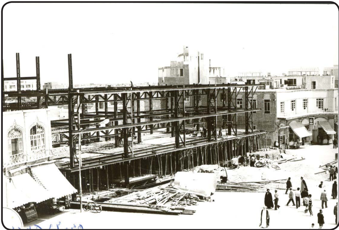
احداث ساختمان دارالتولیه (اسکلت ها)، سال ۱۳۵۵
