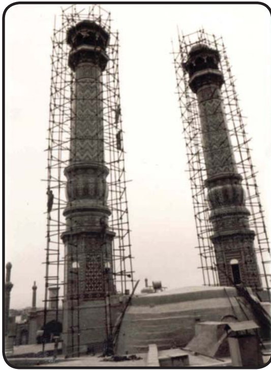
ترمیم و بازسازی مناره های ایوان آینه
