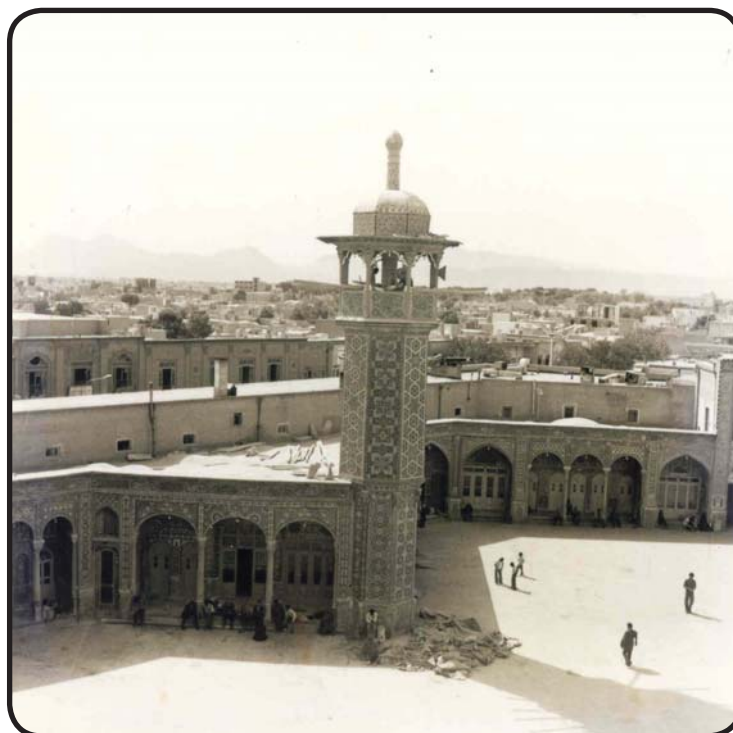
تعمیر گلدسته های ضلع شرقی صحن اتابکی - دهه ۱۳۵۰
