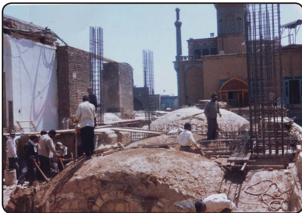
آلبوم تعمیرات ساختمانی پشت بام حرم مطهر، سال ۱۳۷۸
