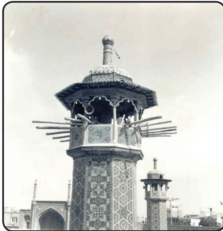
تعمیر گلدسته های ضلع شرقی صحن اناپکی - دهه ۱۳۵۰
