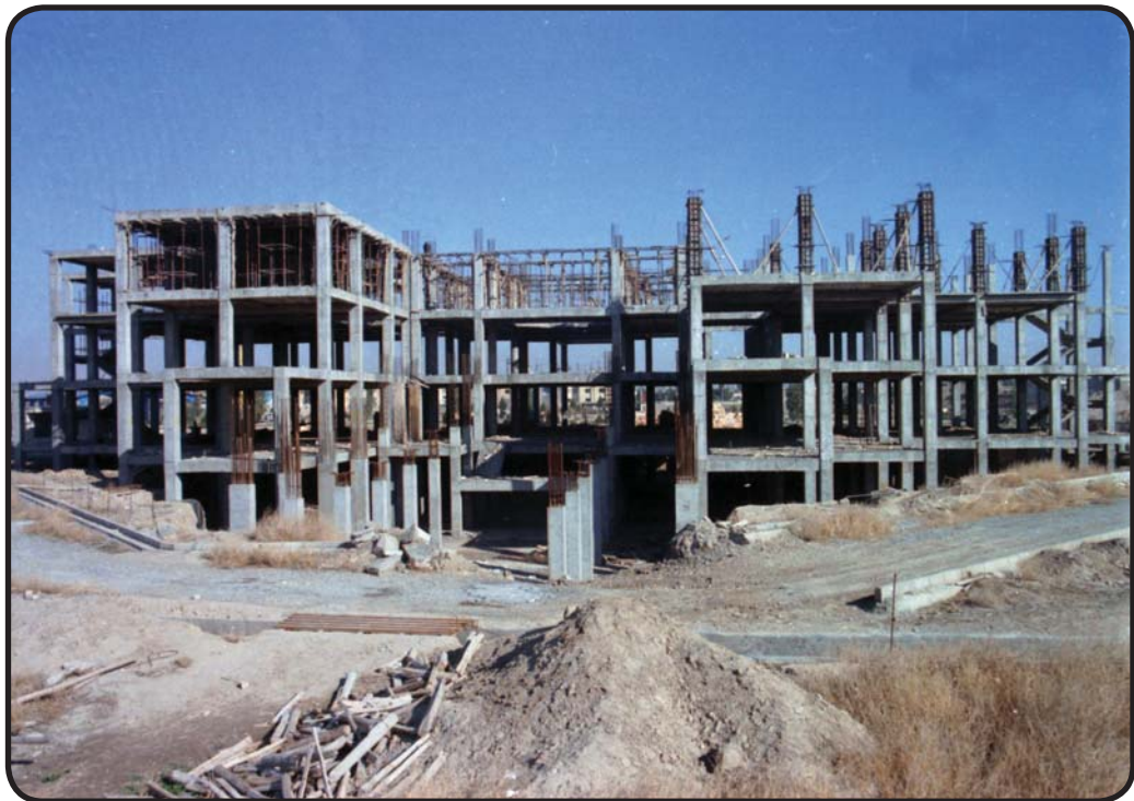
آلبوم روند پیشرفت در پروژه فرهنگی ورزشی آستانه (پژوهشکده علامه طباطبائی)
