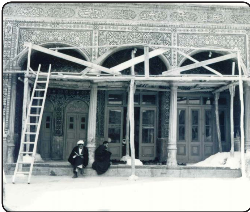
مرمت و بازسازی حجرات صحن اتابکی - دهه ۱۳۴۰
