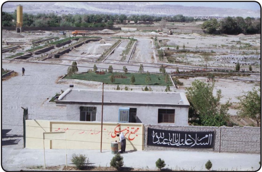
آلبوم روند پیشرفت در پروژه فرهنگی ورزشی آستانه (پژوهشکده علامه طباطبائی)
