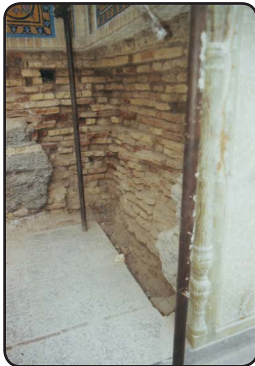
مرمت دیوار های بیرون حجره ای در صحن عتیق، سال ۱۳۸۰
