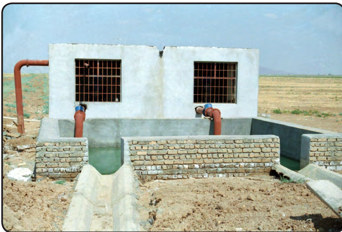
موتور خانه آب جهت آبیاری محصولات کشاورزی
