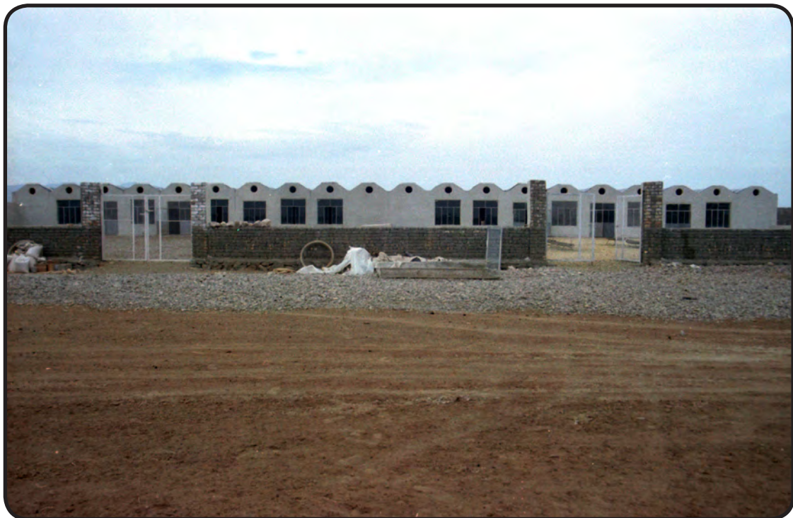
عکس‌ها مربوط به ساختمان دامداری از موقوفات آستانه
